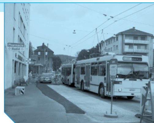
Les deux arrêts t1 «Chailly Village» ont été déplacés au sud de la chaussée afin de réaménager la partie nord. Les voyageurs empruntent des quais provisoires.
