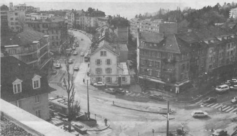
VUE PLONGEANTE SUR LE PONT DE CHAILLY ET L'AVENUE DE CHAILLY
